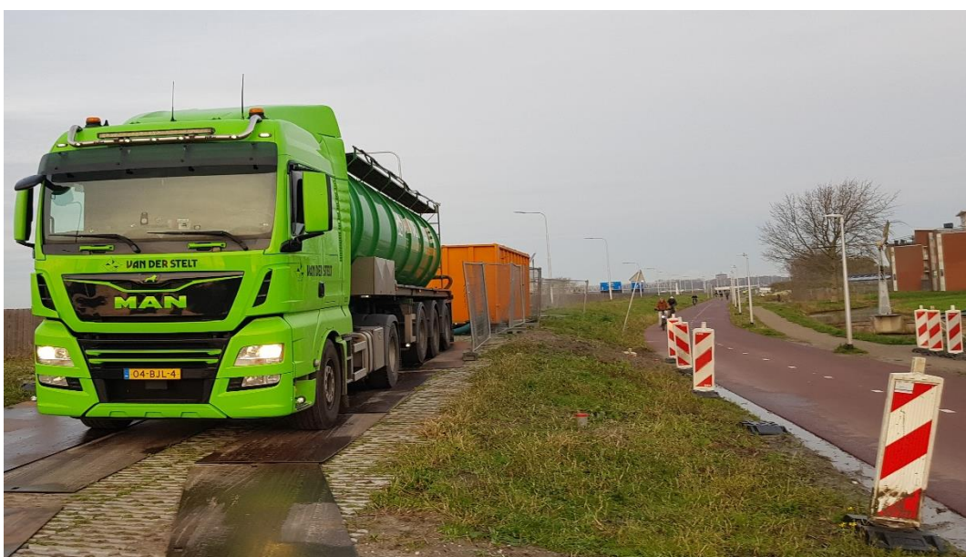
Foto 2: zicht op de opslagcontainer en een tankwagen vanuit zuidoostelijke richting.
